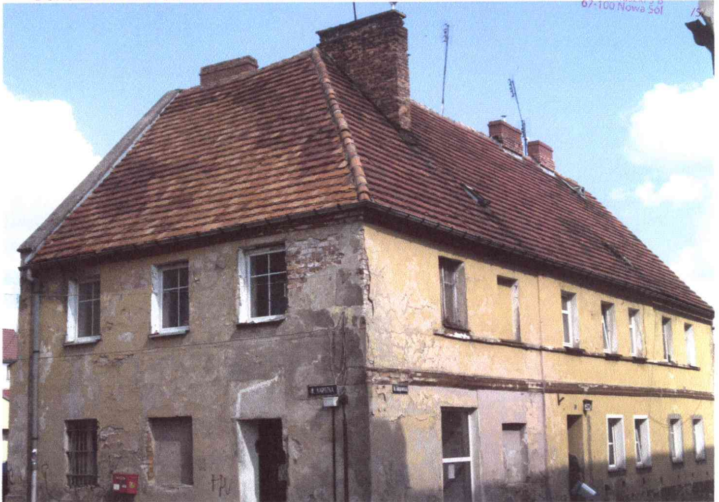
WIDOK POŁĄCI DACHU BUDYNKU ul. GŁOGOWSKA Nr 38 OD ul. GŁOGOWSKIEJ I OD ul. NAROŻNEJ
