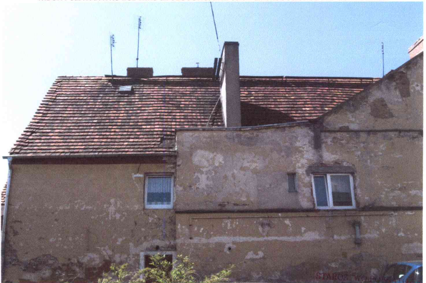
WIDOK FRAGMENTU DACHU BUDYNKU ul. GŁOGOWSKA Nr 38 OD STRONY PÓŁNOCNEJ
