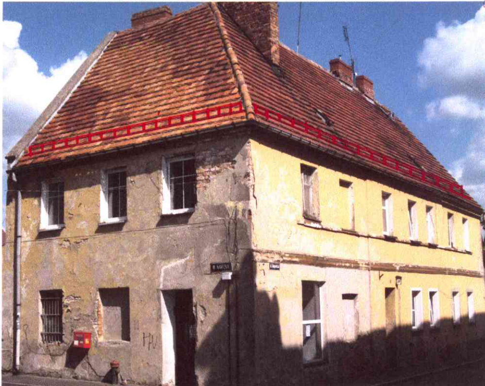
WIDOK POŁĄCI DACHU BUDYNKU ul. GŁOGOWSKA Nr 38 OD ul. GŁOGOWSKIEJ I OD ul. NAROŻNEJ
