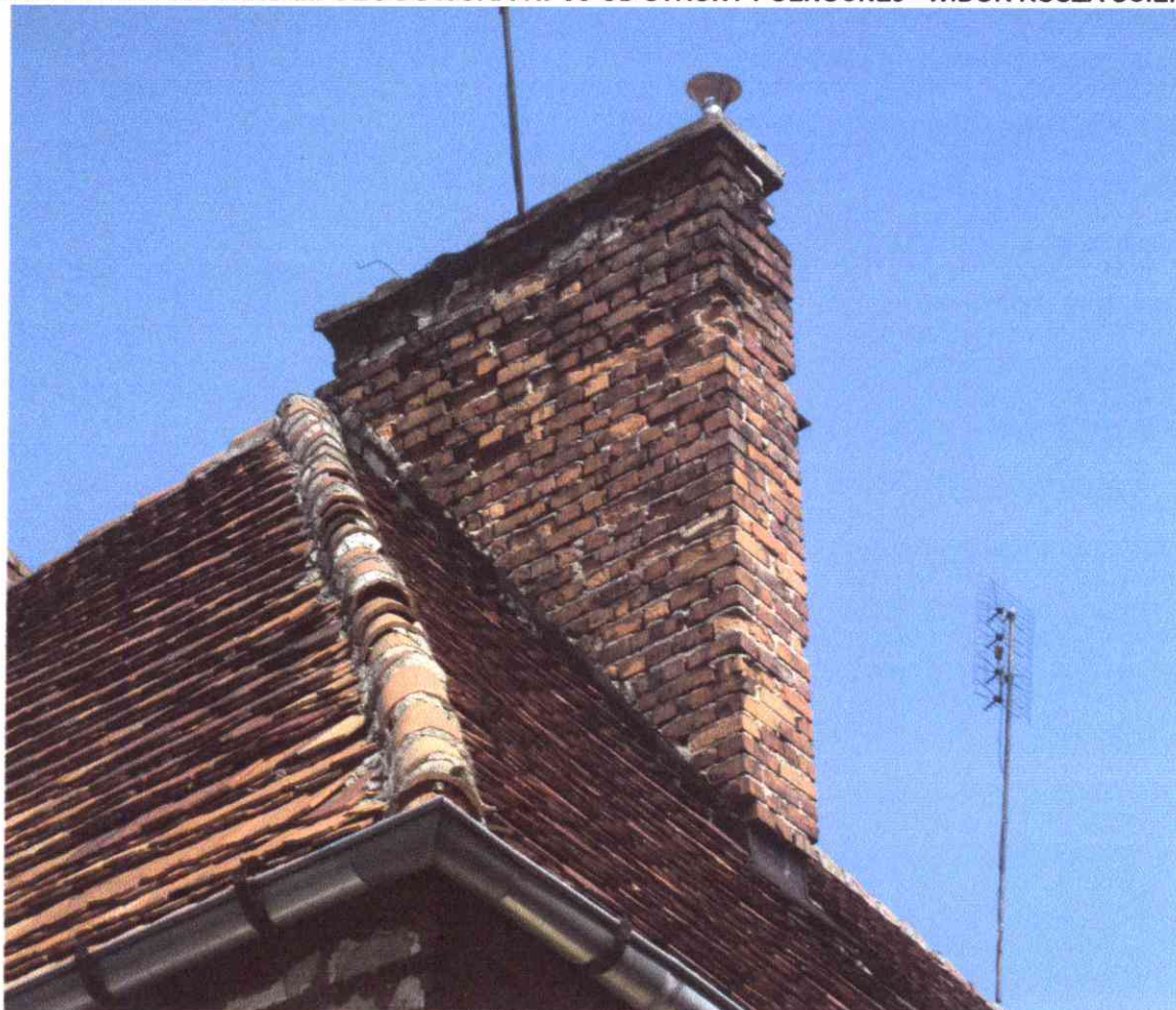
FRAGMENT DACHU BUDYNKU ul. GŁOGOWSKA Nr 38 –WIDOK KOMINA
